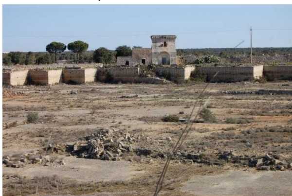
FIG. 11 - Territorio di Acquarica. Il paesaggio delle cave dismesse lungo il tracciato della Via Sallentina.
