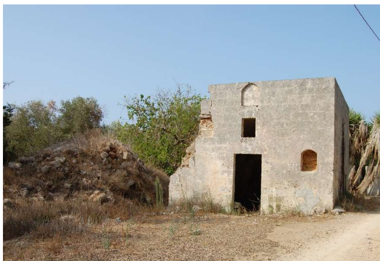
FIG. 39 - Complesso edilizio di S. Riggio: ruderi
