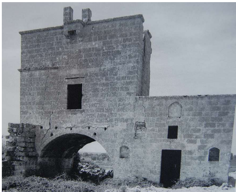
FIG. 38 - Complesso edilizio di S. Riggio in una foto degli anni '70.
