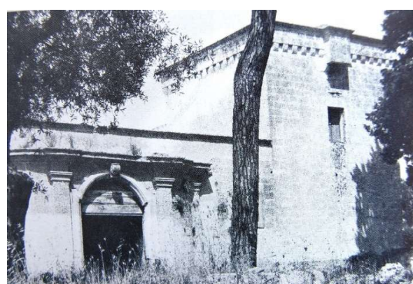
FIG. 37 - Masseria del Feudo: il fabbricato settecentesco attiguo alla torre.
