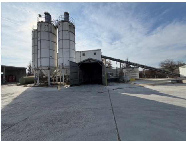
Impianto esistente di betonaggio che verrà riattivato
