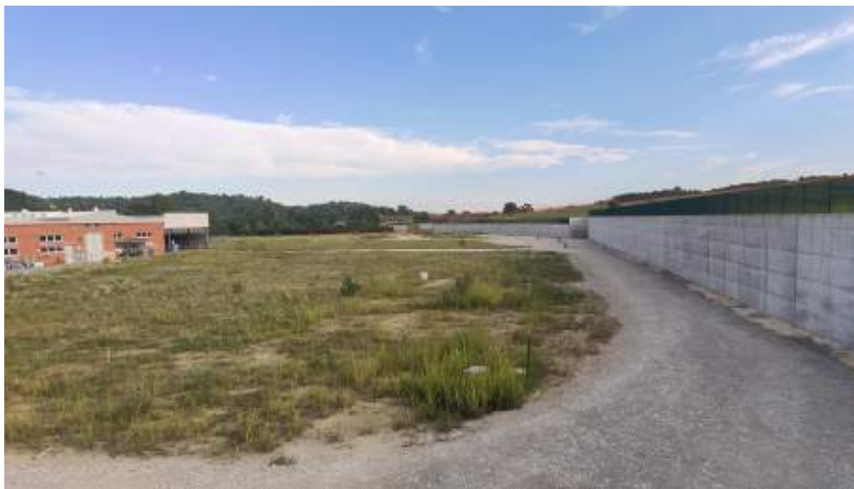
Vista lato Strada Pola con indicazione del limite della fascia di rispetto – prima dell'intervento
