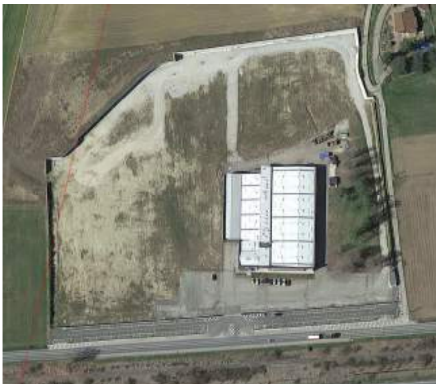
Vista aerea - prima dell'intervento
