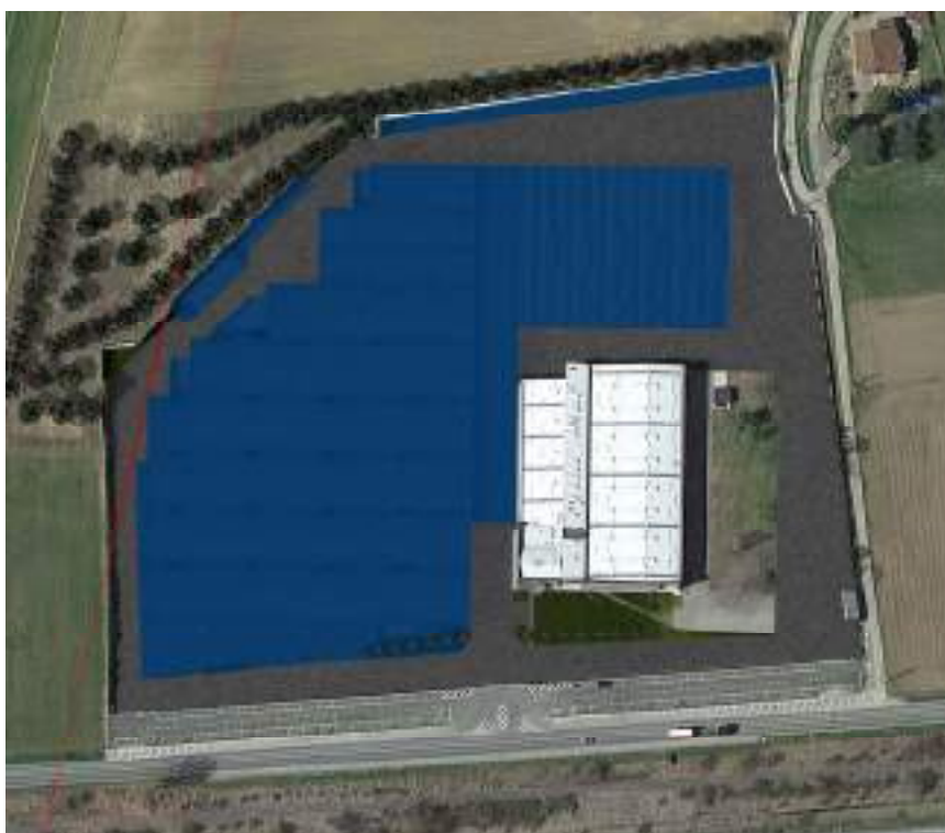
Vista aerea - dopo l'intervento
