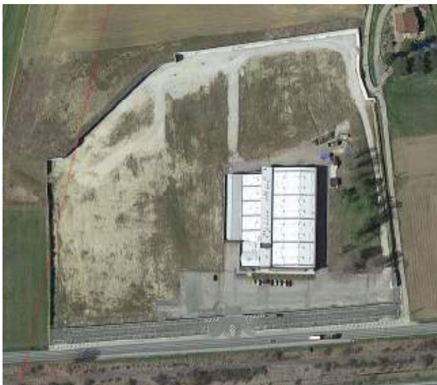
Vista aerea - prima dell'intervento
