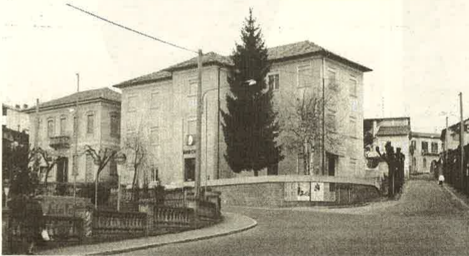
Gli edifici che ospitano gli Uffici Comunali
