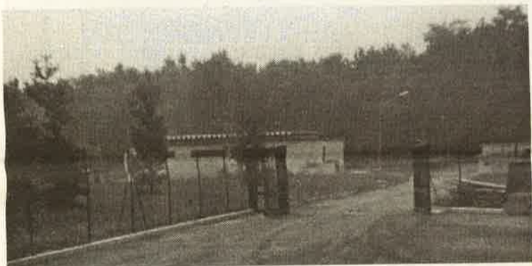
L'ingresso al grande impianto di depurazione di Vergiate sito in via S. Eurosia
