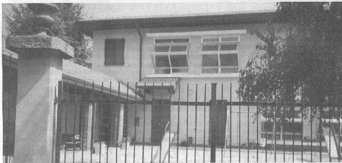
La Scuola Materna Statale di Sesona. Passata al Comune per decisione del vecchio Consiglio di Amministrazione, è stata completamente ristrutturata (Foto di M. Fumagalli)
