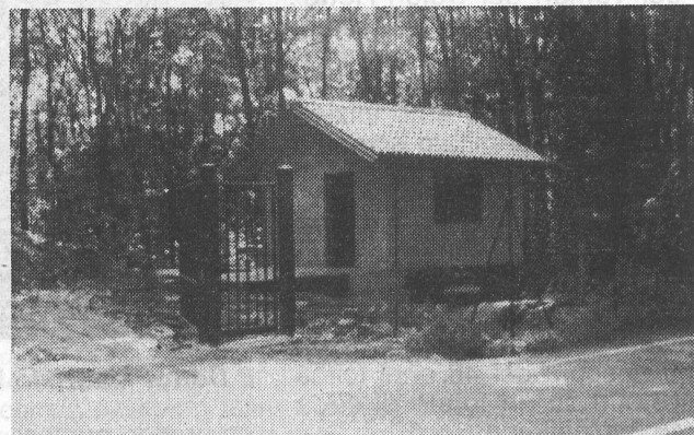
I lavori per la costruzione del nuovo pozzo idrico vicino la ex Tematex di Corgeno (locale quadri). (Foto M. De Troia)
