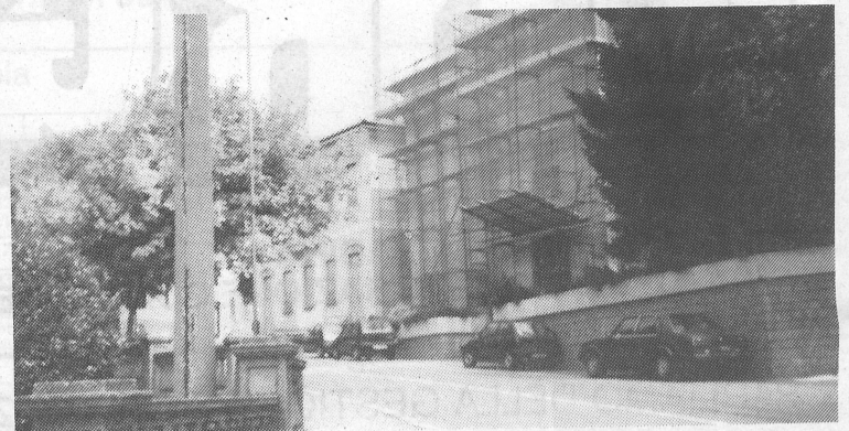
I lavori di ristrutturazione del Palazzo Comunale. Sono previsti anche gli ascensori per i portatori di handicap
