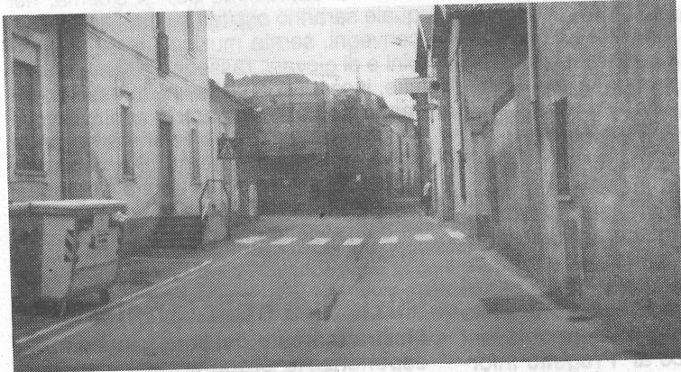
Corgeno: il caseggiato ospitante l'ufficio postale viene completamente ristrutturato per adibirlo ad usi sociali comunali (foto Massimo Fumagalli)
