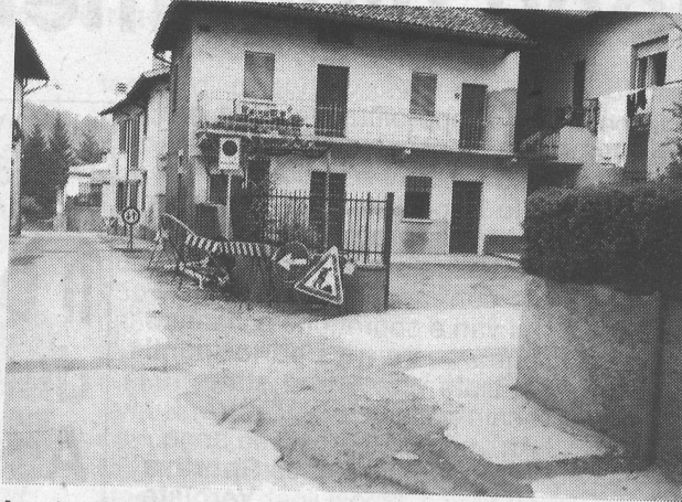
In via Cusciano (nella foto) e in tutta la parte bassa di Vergiate sono in corso i lavori per costruire una nuova rete idrica onde garantire meglio la distribuzione dell'acqua potabile (Foto Massimo Fumagalli)
