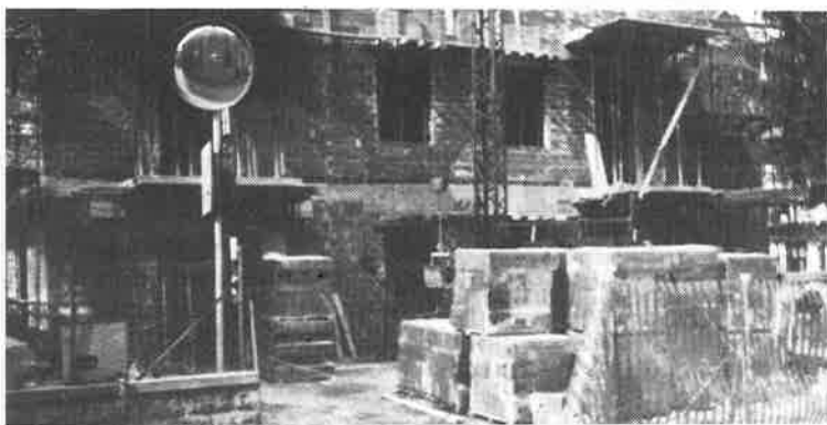
I lavori di ristrutturazione della ex-Scuola Elementare di Corgeno per realizzare un centro di aggregazione giovanile, mini alloggi per anziani e un centro sociale. Costo previsto L. 570 milioni.
