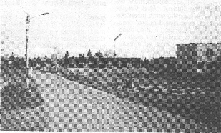
La nuova palestra comunale in fase di costruzione a Cimbri (Foto di Michele De Troia)
