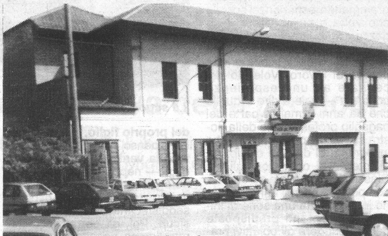
Il nuovo Centro Polivalente, soprastante la casa del popolo di Vergiate, realizzato dal comune
