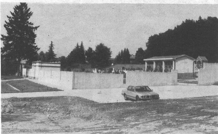
I lavori per l'ampliamento del cimitero di Corgeno e costruzione parcheggio e marciapiede (foto Michele De Trola)
