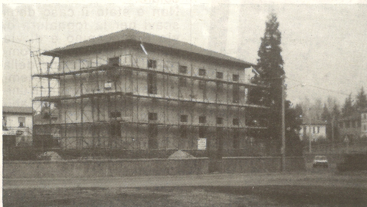
L'ex scuola di Cimbri in fase di ristrutturazione per adibirla ad usi sociali comunali
