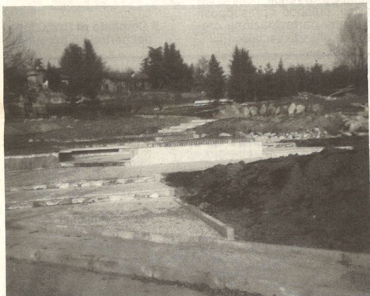
I lavori per la costruzione del nuovo Parco Pubblico attrezzato di Via Stoppani (Asilo nido)
