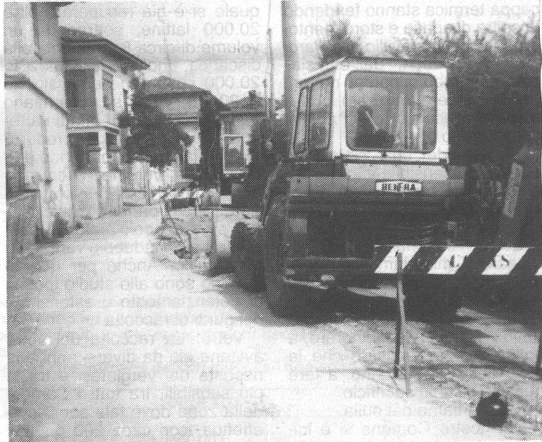
I lavori per la costruzione di nuovi tratti di rete fognaria continuano. A Cimbro (nella foto) l'impianto generale di tutto il paese è quasi ultimato
