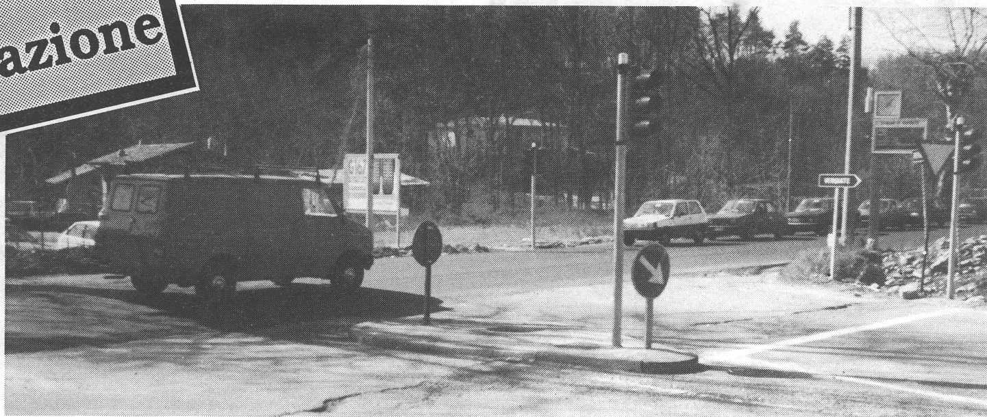
L'impianto semaforico all'incrocio del Sempione installato dal Comune
