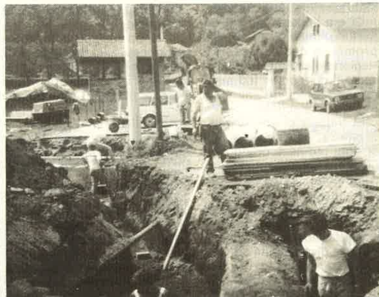
I lavori per la costruzione del nuovo collettore fognario di Cimbrowe — Cuirone.
