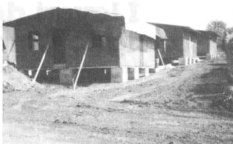
Le tre cassette prefabbricate in via di sistemazione destinate ad ospitare provvisoriamente degli sfrattati.
