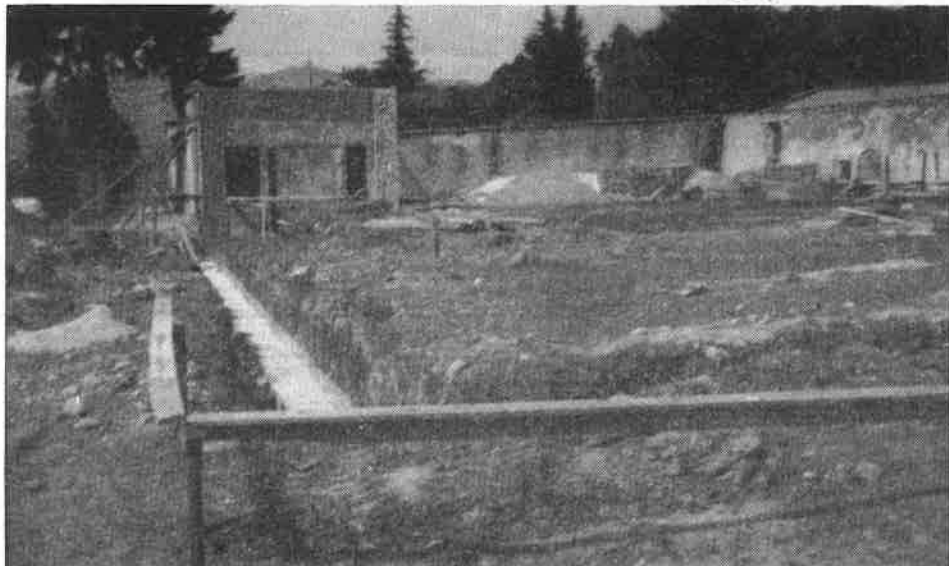
I lavori per l'ampliamento e la sistemazione del cimitero di Corgeno. Costo preventivato 180 milioni di lire circa
