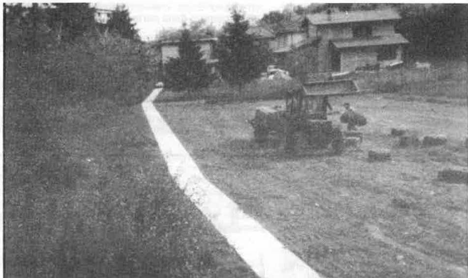
Un collegamento di scarico per le tombinature di via Cusciano, Piave e Locatelli in via di costruzione. Costo 110 milioni di lire
