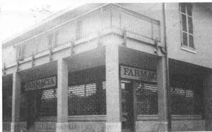
La nuova sede della farmacia municipalizzata realizzata all'interno del nuovo centro socio-sanitario
