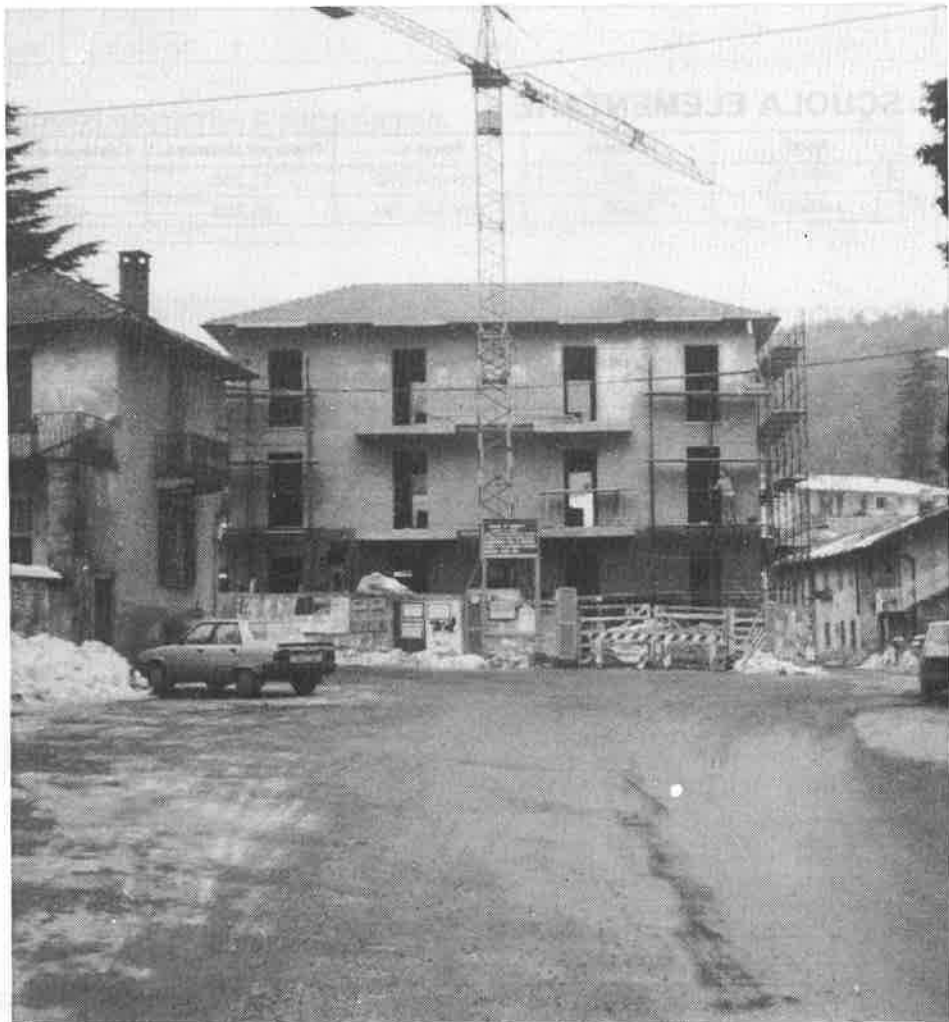
Dalla ristrutturazione della ex scuola di Culrone si ricavano 4 mini-appartamenti, il centro sociale e uno studio medico
