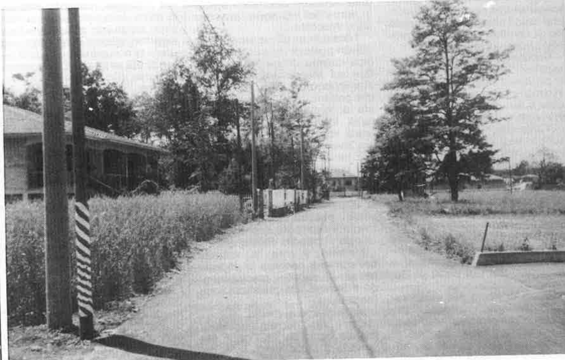
La via S. Eurosia asfaltata il mese scorso. Costo 75 milioni
