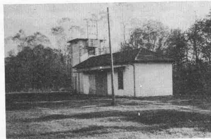
La stazione di sollevamento acqua posta in località "Fontanone"
