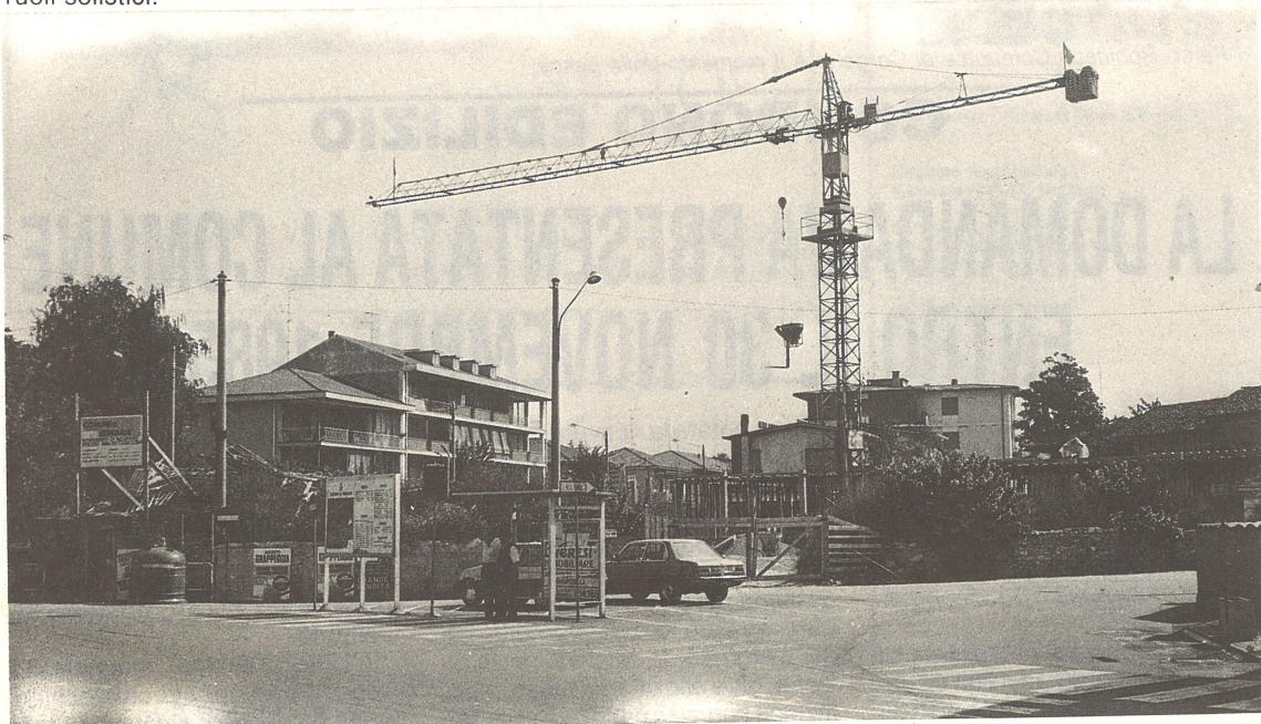
Sono in pieno svolgimento i lavori per la costruzione del nuovo centro Socio-Sanitario.
