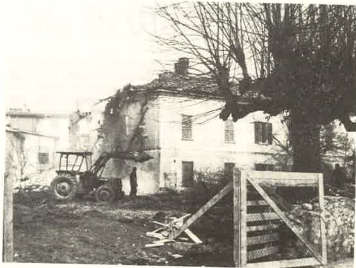
Iniziati i lavori del Centro Socio-Sanitario (ex Casa Cova)
