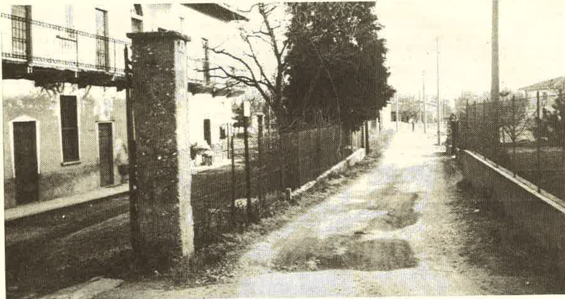
Via della Valletta: una delle 25 strade passate comunali.
