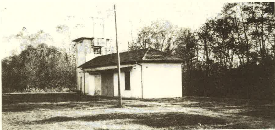
La stazione di sollevamento acqua posta in località "Fontanone".
