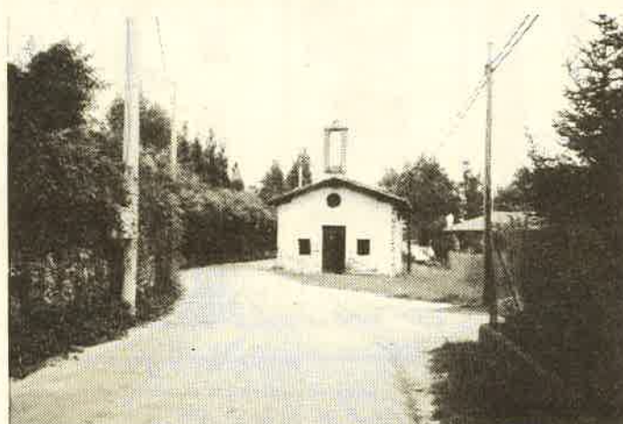
Via Torretta: sono in corso i lavori per la rete fognaria.
