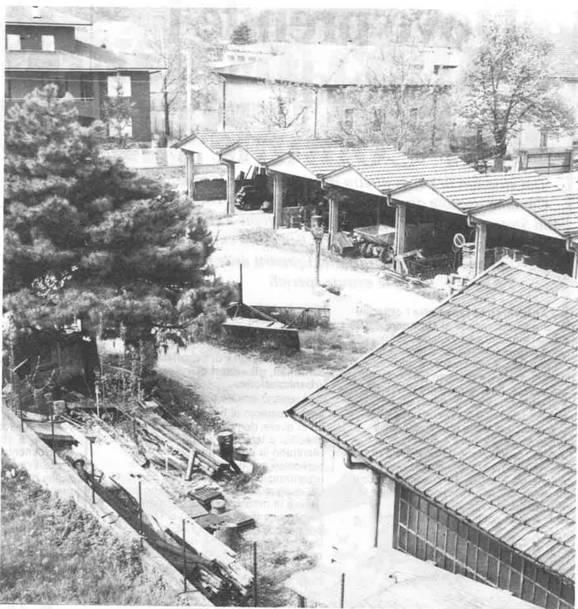
I magazzini di via Cusciano acquisiti dalla amministrazione con questo Bilancio
