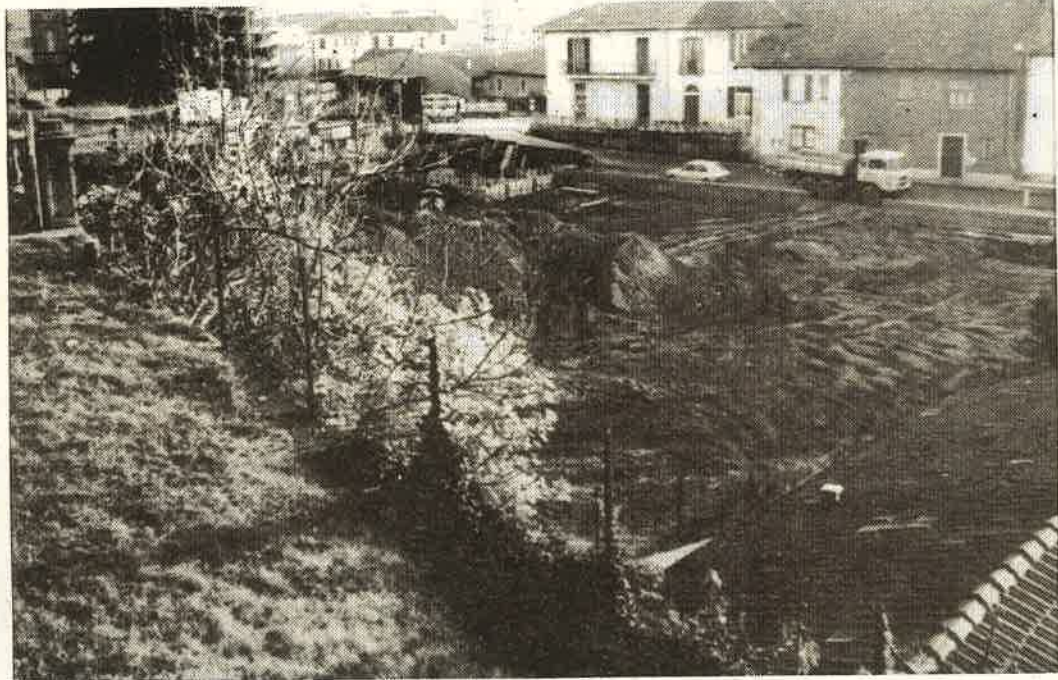
"Lavori in corso nell'area destinata a verde pubblico"
