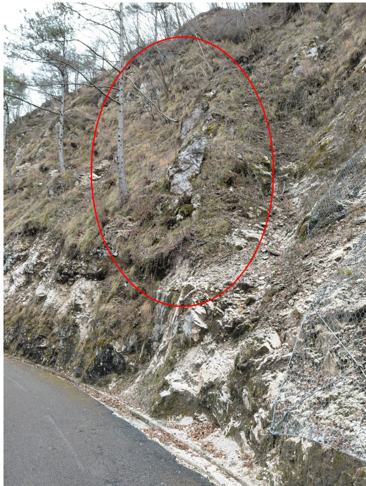
FOTO Masso da demolire e/o rimuovere
