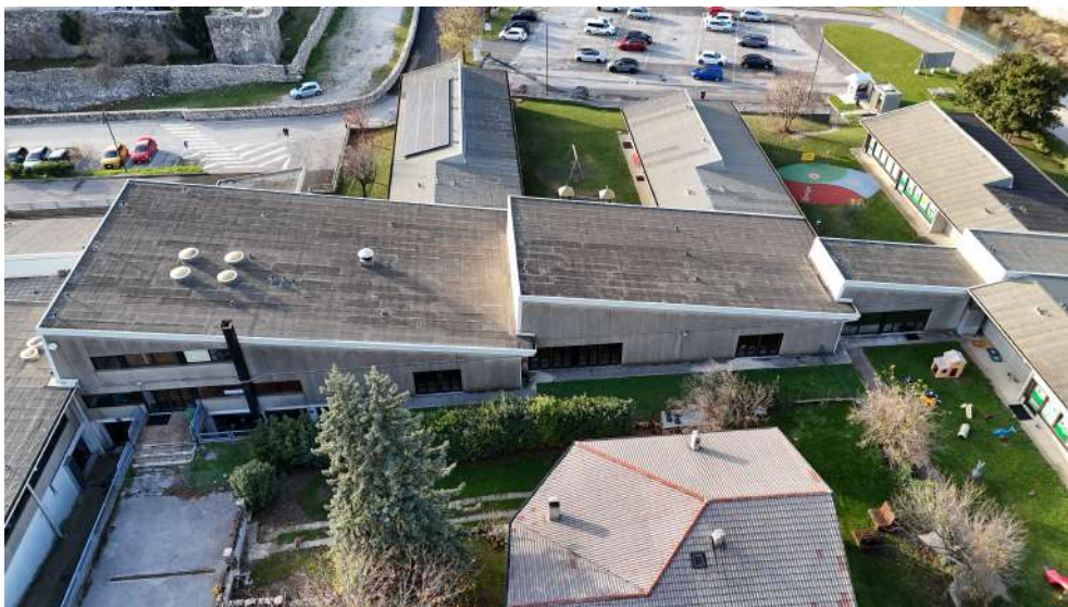
Viste aeree dell'edificio esistente
