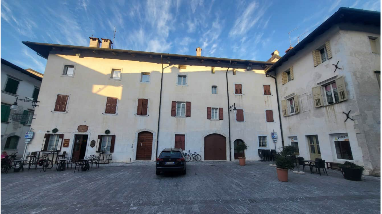
Figure 50: Stato di fatto: Edificio H su cui saranno installati i nuovi corpi illuminanti
