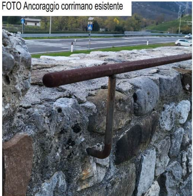
Figura 14: Stato di fatto – Vista del corrimano in acciaio ossidato
