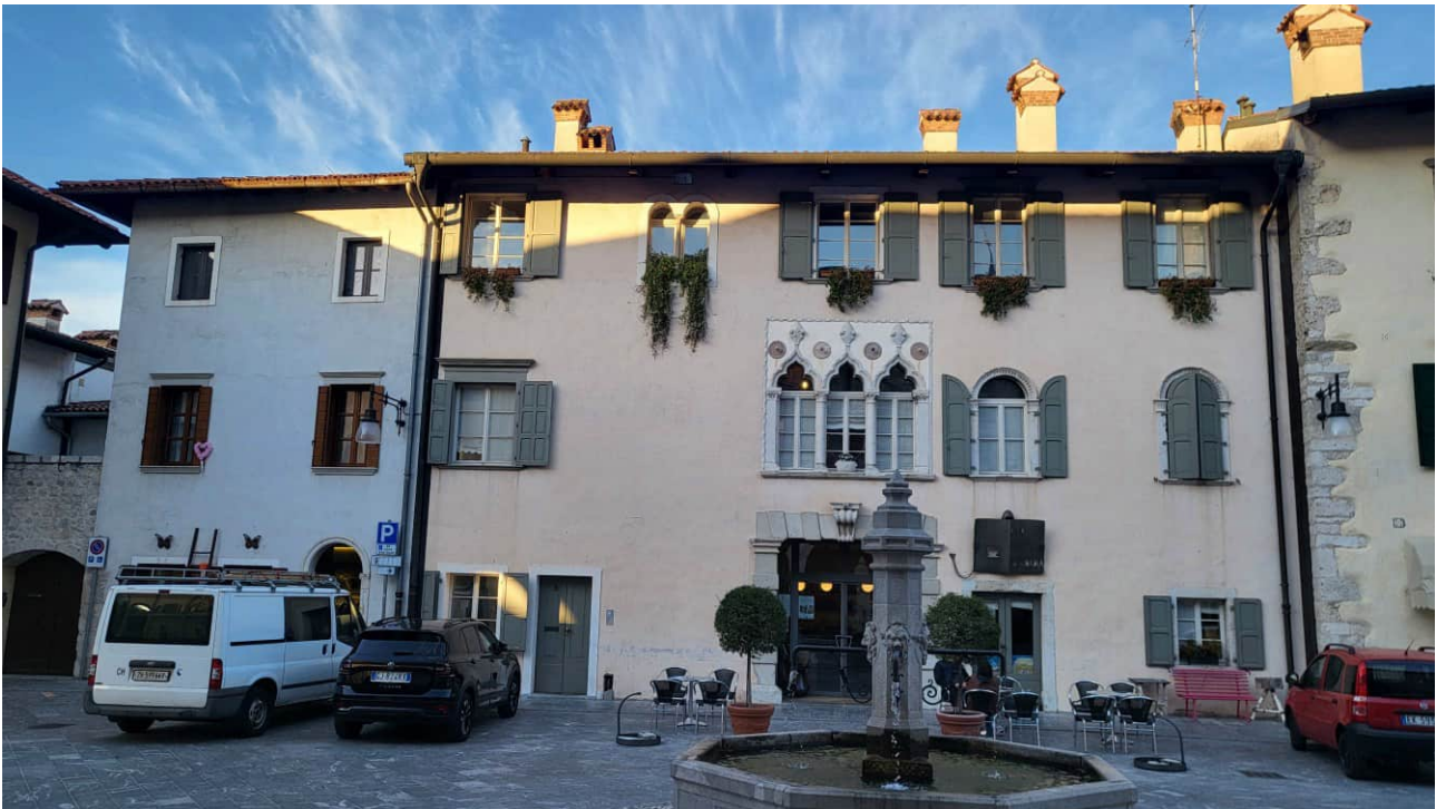
Figure 46: Stato di fatto: Edifici A e B su cui saranno installati i nuovi corpi illuminanti
