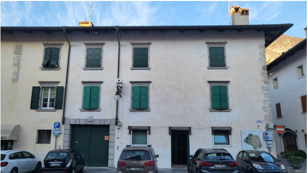
Figure 48: Stato di fatto: Edifici C e D su cui saranno installati i nuovi corpi illuminanti
