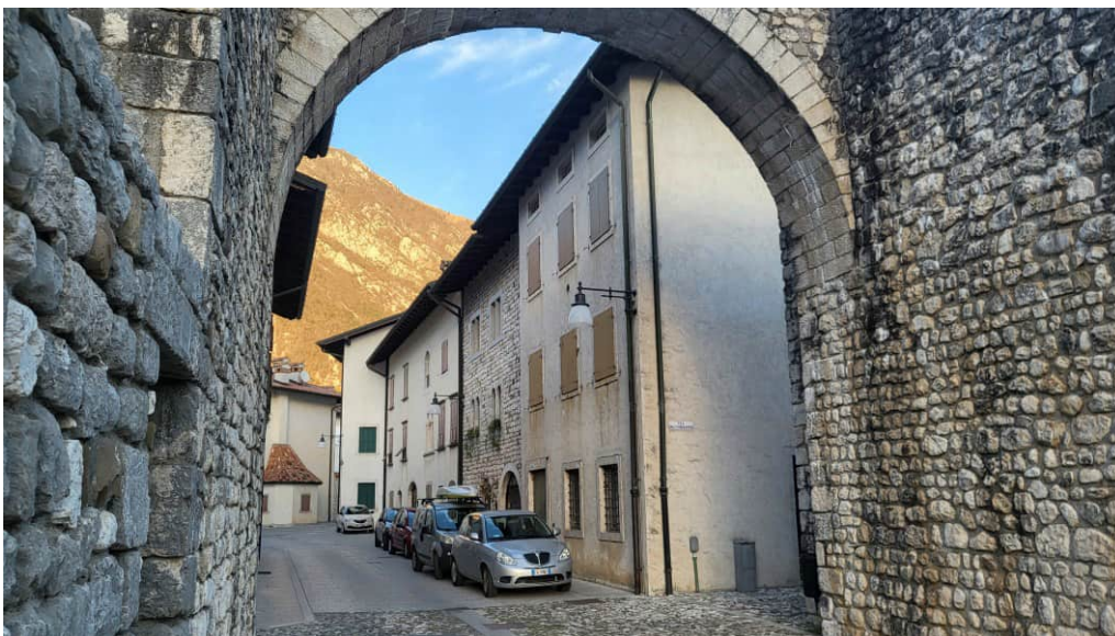
Figure 39: Stato di fatto – Edificio su cui sarà installato il nuovo corpo illuminante
