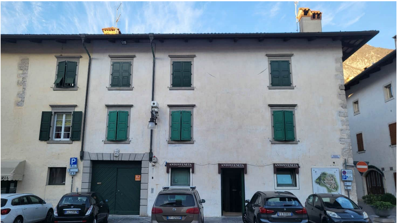
Figure 22: Stato di fatto: Edifici C e D su cui saranno installati i nuovi corpi illuminanti
