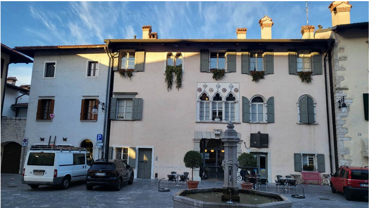
Figure 20: Stato di fatto: Edifici A e B su cui saranno installati i nuovi corpi illuminanti
