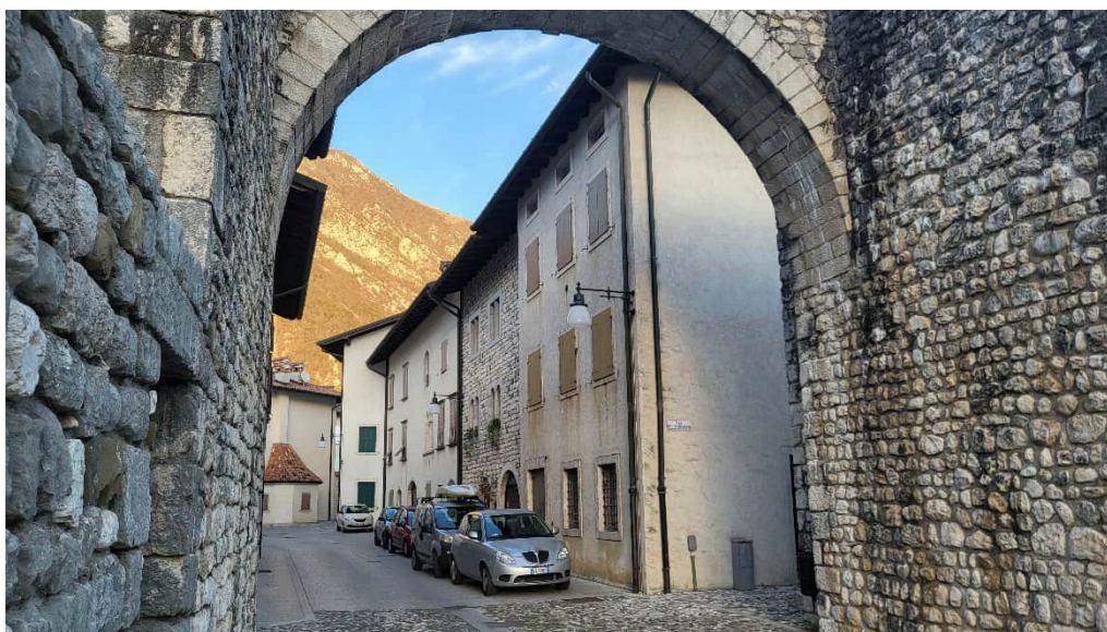
Figure 13: Stato di fatto – Edificio su cui sarà installato il nuovo corpo illuminante
