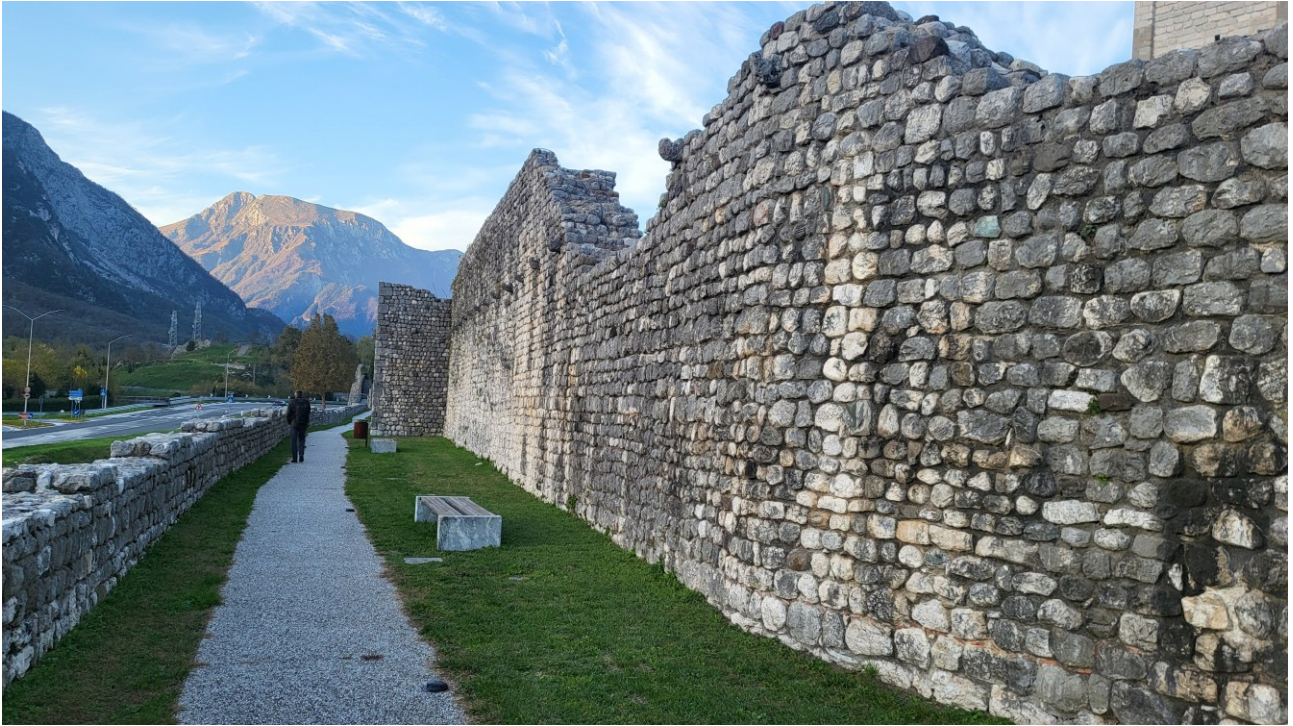
Figura 10: Stato di fatto – Vista del percorso esistente
