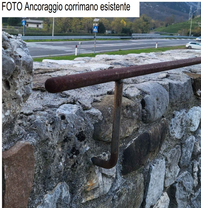
Figura 14: Stato di fatto – Vista del corrimano in acciaio ossidato
