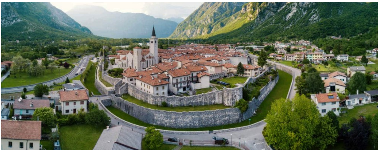
Figura 1: Veduta panoramica di Venzone e della cinta muraria
