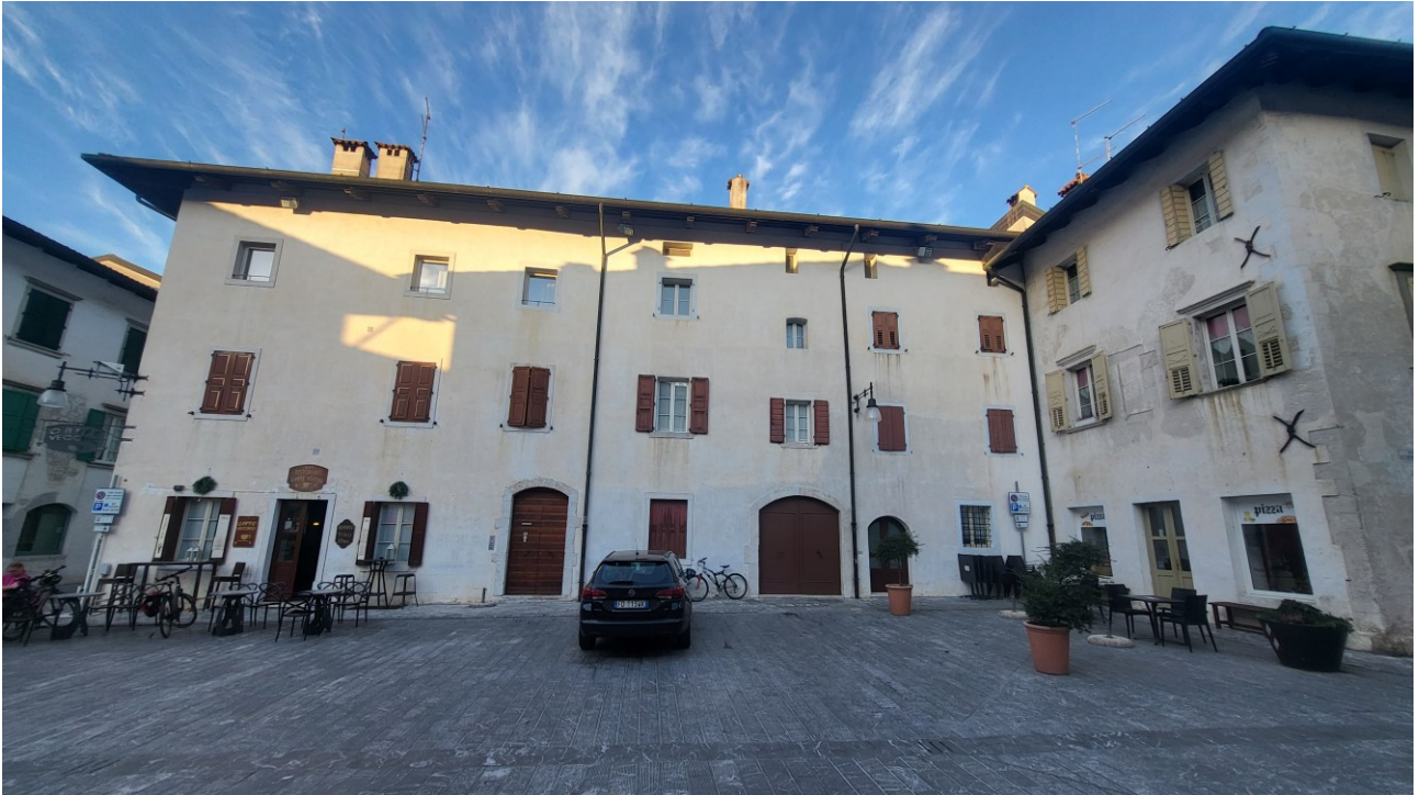
Figure 50: Stato di fatto: Edificio H su cui saranno installati i nuovi corpi illuminanti
