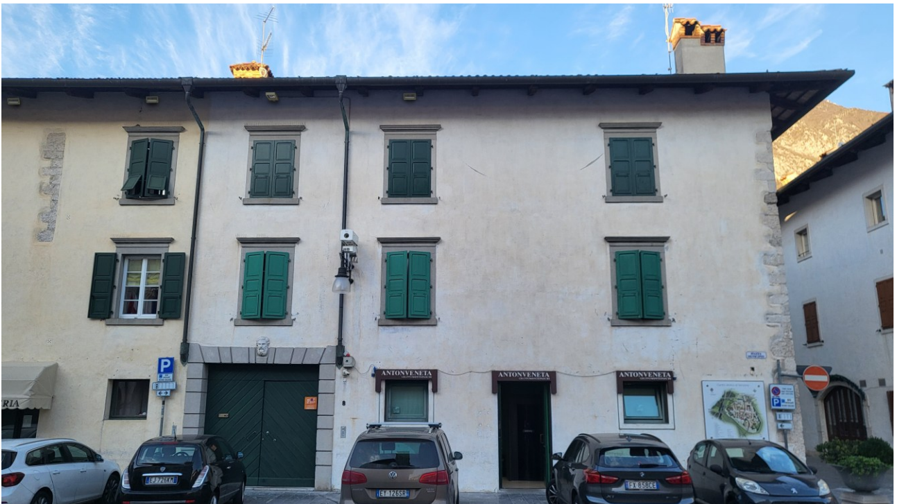
Figure 49: Progetto: Simulazione dei nuovi corpi illuminanti sugli edifici C e D
