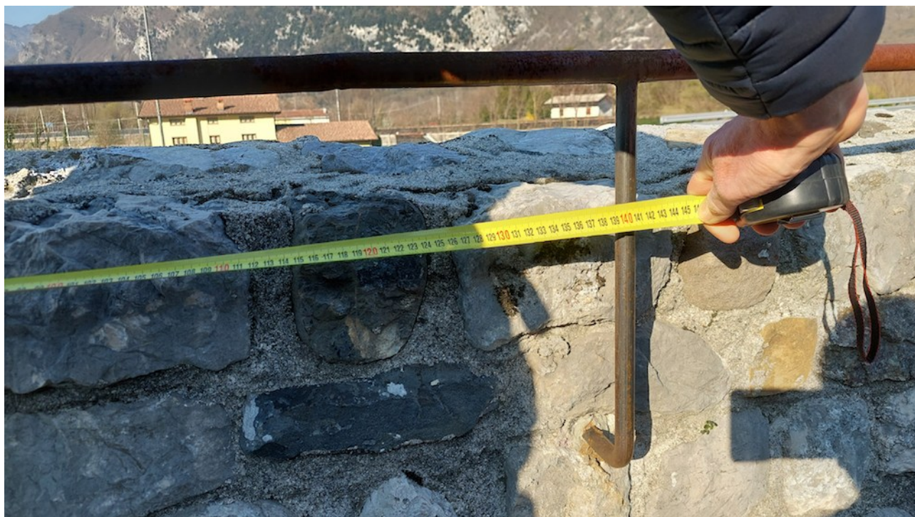
Figura 14: Stato di fatto – Vista del corrimano in acciaio ossidato
