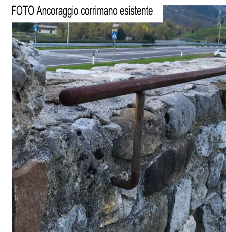
FOTO Ancoraggio corrimano esistente
