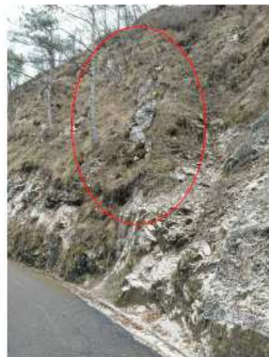
FOTO Masso da demolire e/o rimuovere
