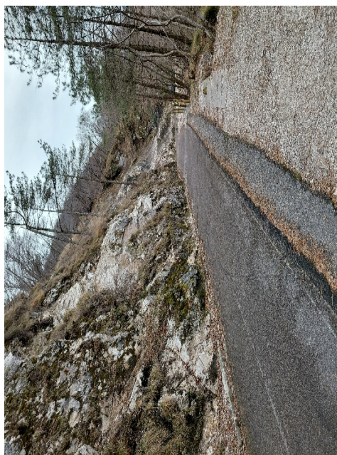
Figura 1 Stato del versante a seguito sradicamento alberi e colate detritiche e massi medio piccoli
