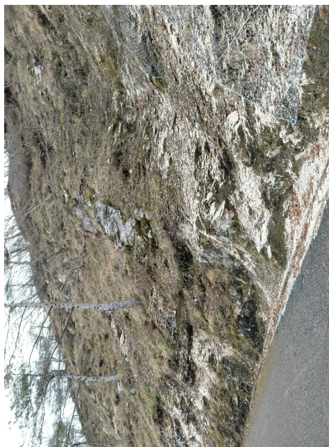
Figura 1 Stato del versante a seguito sradicamento alberi e colate detritiche e massi medio piccoli
