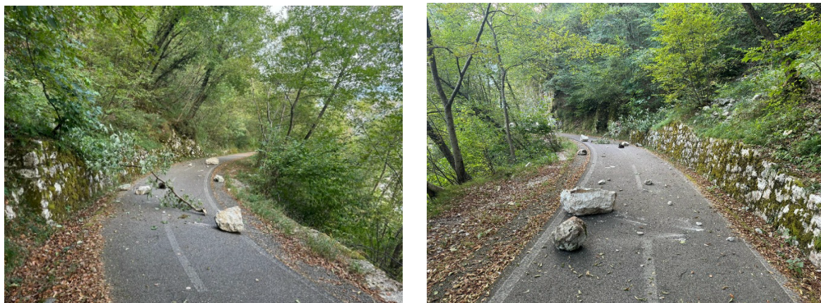
Vista dell'area interessata da caduta massi (Volume max 0,25 mc) nel corso del 2024 dove disporre nuova barriera paramassi
