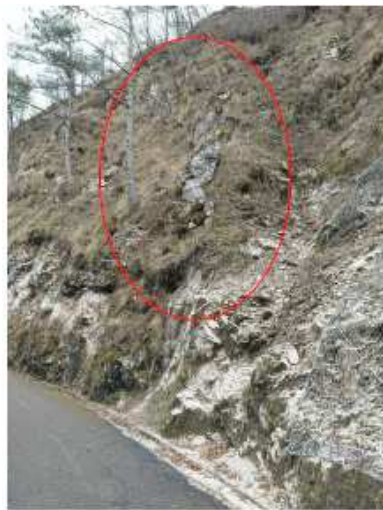
FOTO Masso da demolire e/o rimuovere
