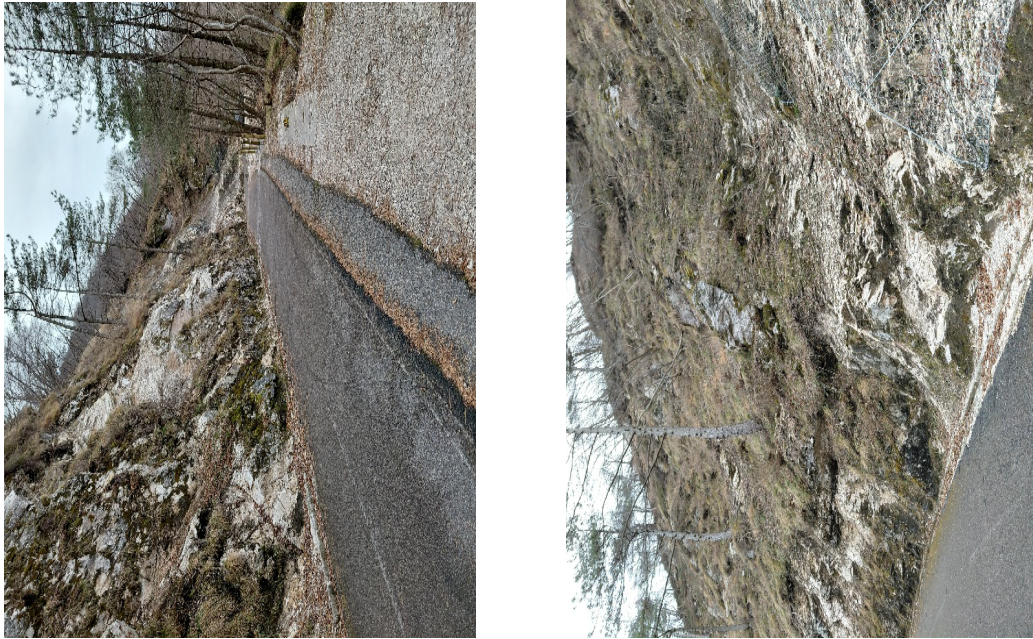
Figura 1 Stato del versante a seguito sradicamento alberi e colate detritiche e massi medio piccoli
