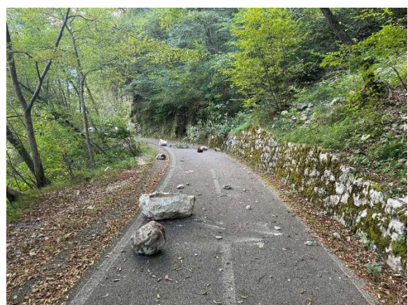
Vista dell'area interessata da caduta massi e nel corso del 2024 e dove disporre nuova barriera paramassi
