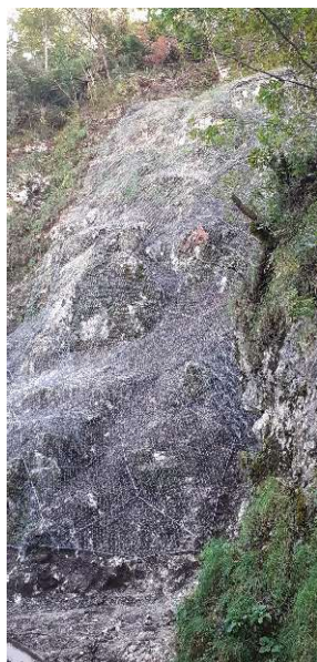
Foto reti in aderenza eseguite progetto 2024 da integrare con progetto 2026
