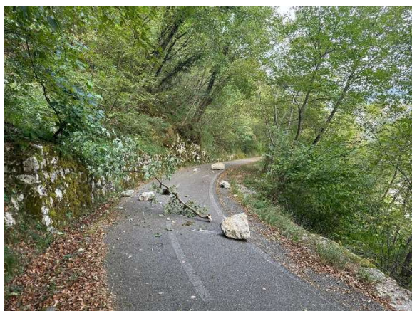
Vista dell'area interessata da caduta massi e nel corso del 2024 e dove disporre nuova barriera paramassi
