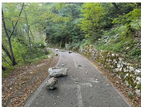
Vista dell'area interessata da caduta massi e nel corso del 2024 e dove disporre nuova barriera paramassi
