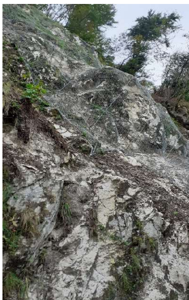
Foto reti in aderenza eseguite progetto 2024 da integrare con progetto 2026
