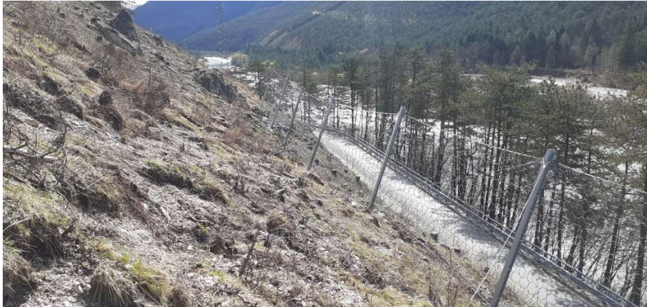
Barriera Paramassi simile montata in altro intervento simile (Post-intervento)
