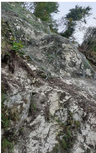
Foto reti in aderenza eseguite progetto 2024 da integrare con progetto 2026 Reti in aderenza eseguite scarpata anno 2024
