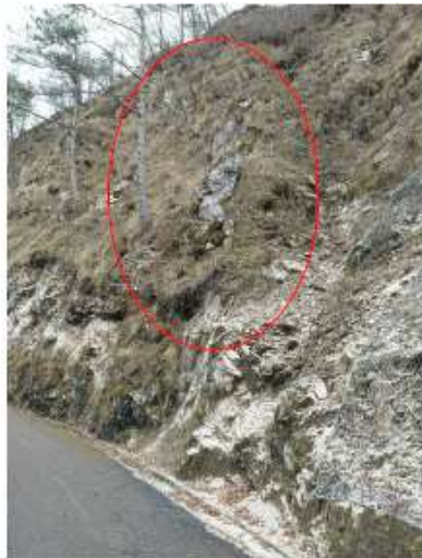
FOTO Masso da demolire e/o rimuovere
