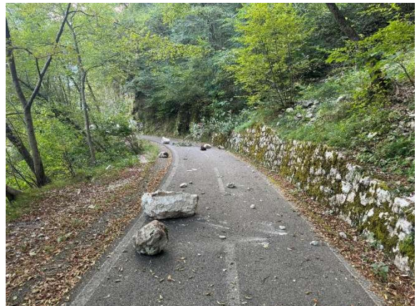
Vista dell’area interessata da caduta massi (Volume max 0,25 mc) nel corso del 2024 dove disporre nuova barriera paramassi
