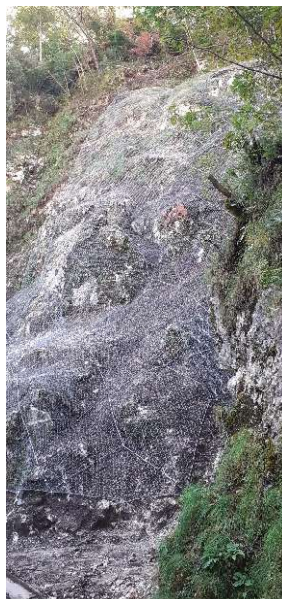
Foto reti in aderenza eseguite progetto 2024 da integrare con progetto 2026 Reti in aderenza eseguite scarpata anno 2024
