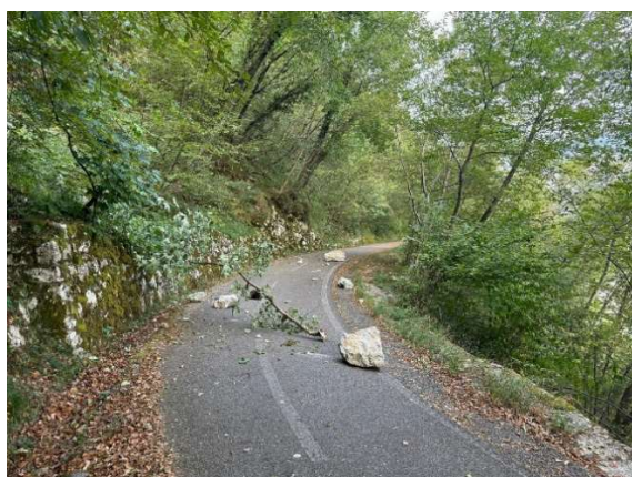
Vista dell’area interessata da caduta massi (Volume max 0,25 mc) nel corso del 2024 dove disporre nuova barriera paramassi
