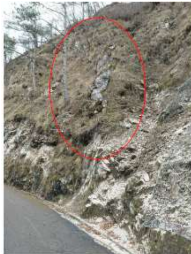
FOTO Masso da demolire e/o rimuovere
