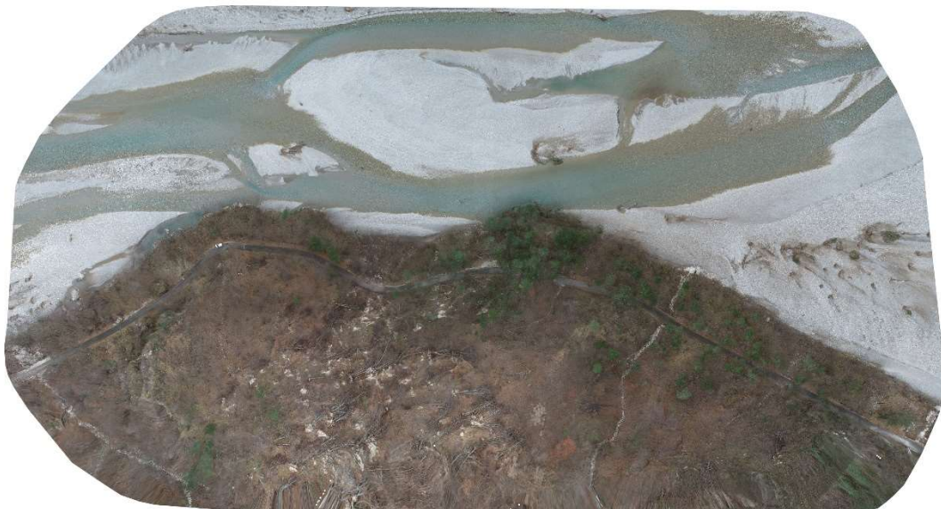
Area reti aderenza e masso da demolire
