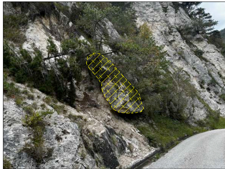
DEMOLIZIONE SPERONE DI ROCCIA 7,60 x 4,20 x 1,00 = 31,92 mc
