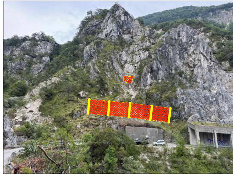
POSA PANNELLI DI RETE IN FUNE TIPO MACCAFERRI HEA PANELS O SIMILARE n°3 - 6 x 3 m POSA BARRIERE PARAMASSI 3000 KJ 32,00 x 5,00 (160 mq)
