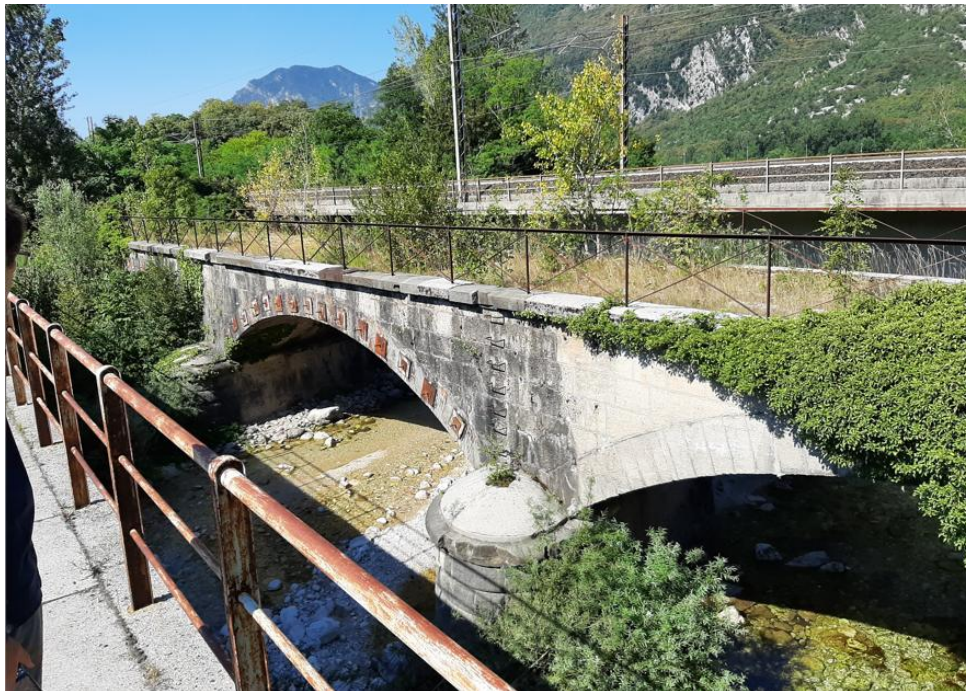
Ponte ad arco in muratura
