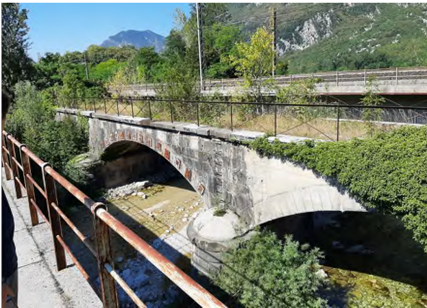
Ponte ad arco in muratura
