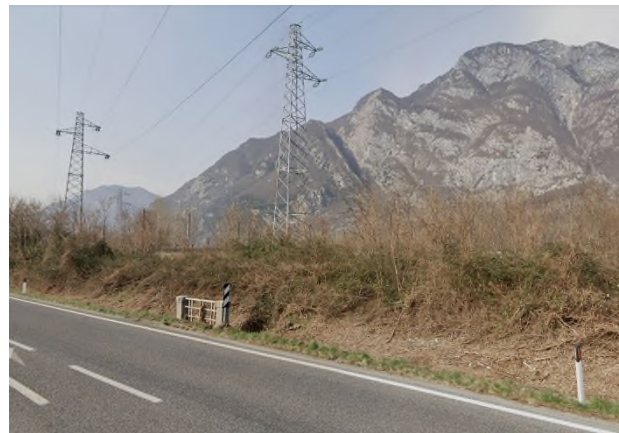
Sedime ex ferrovia nei pressi dell'intersezione tra SS13 e via A. Bidernuccio all'ingresso di Venzone
