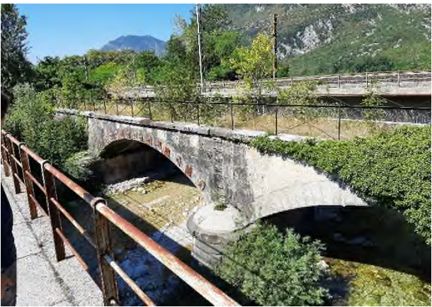
Ponti ferroviari sul Torrente Venzonassa
