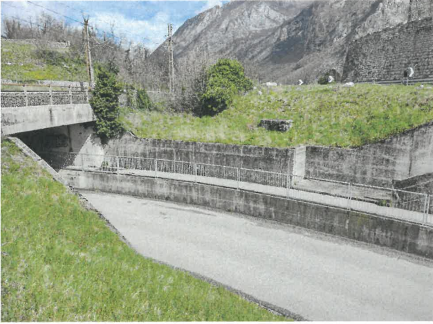
Sottopasso strada per Pioverno (interferente)
