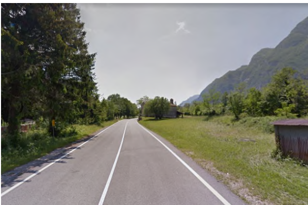
Strada per Portis Vecchio
