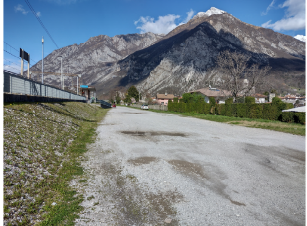
Piazzale stazione ferroviaria di Venzone
