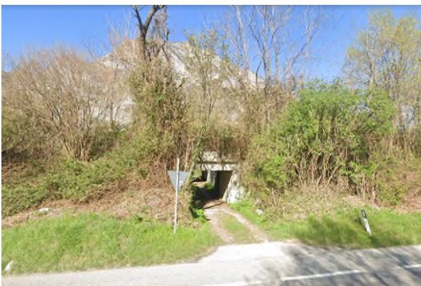
Ponte della ex ferrovia nei pressi della SS13
