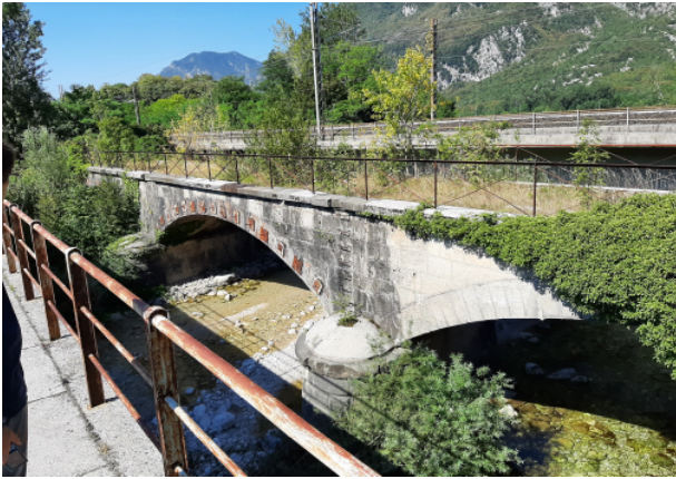
Ponti ferroviari sul Torrente Venzonassa
