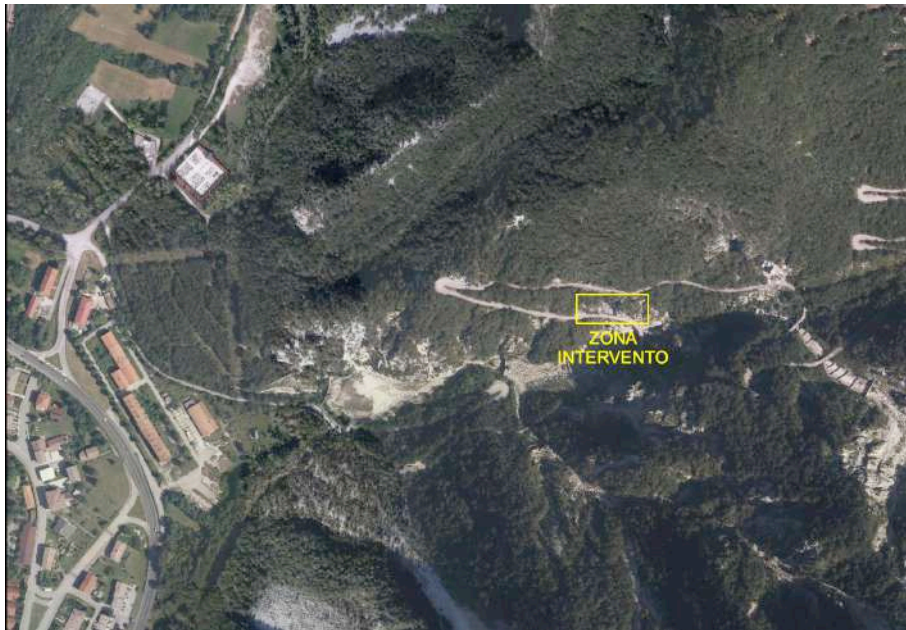
VISTA AEREA DELLA ZONA INTERVENTO
