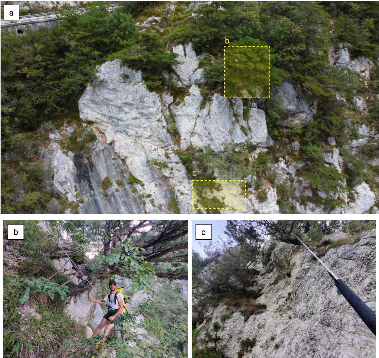
Figura 5. a) Panoramica da drone della parte alta della parete oggetto di dissesto nell'area di intervento 1. b) Dettaglio della Figura 5a in cui è visibile la pianta ancorata all'ammasso roccioso, sono presenti fratture beanti di alcuni centimetri, c) Dettaglio della Figura 5a, in cui l'ammasso roccioso assume un aspetto "scaglioso" essendo fortemente fratturato e detensionato, in modo diffuso sono presenti dei distacchi.
