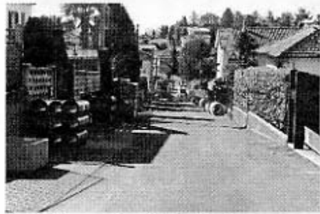
Lavori in corso in via F.lli Bandiera
