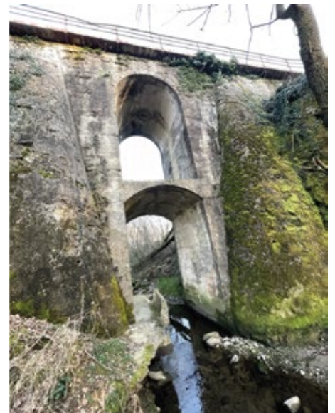
Fig 5. Il Ponte della Ferrovia
